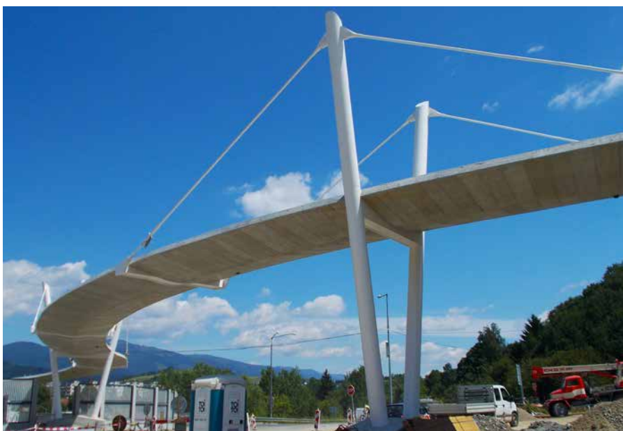
Nosná konštrukcia lávky po odskružení
