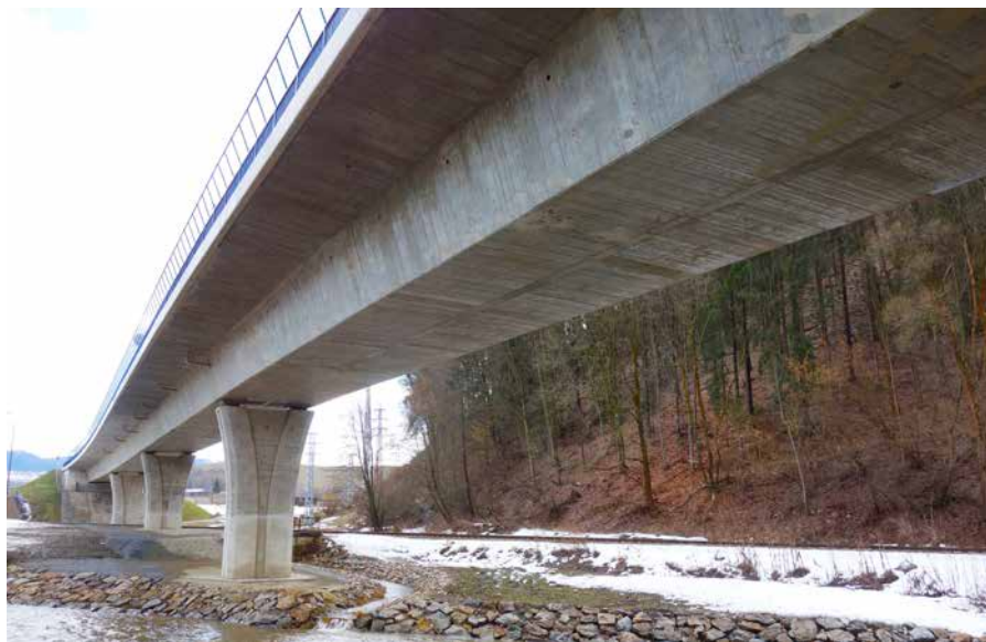
Pohľad na hlavné pole mosta 201
