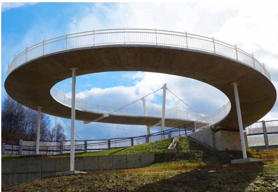
Kruhová rampa lávky
